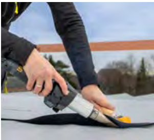
Soldadura de impermeabilizaciones
