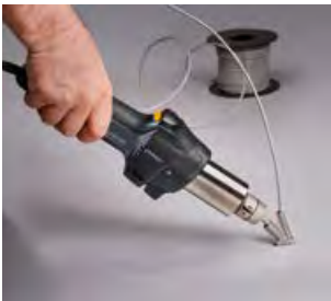
Soldadura suelo de linóleo
