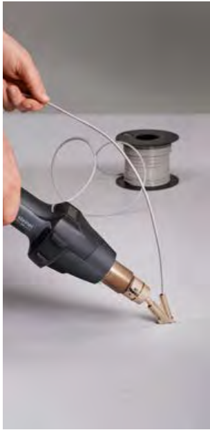
Soldadura suelo de linóleo
