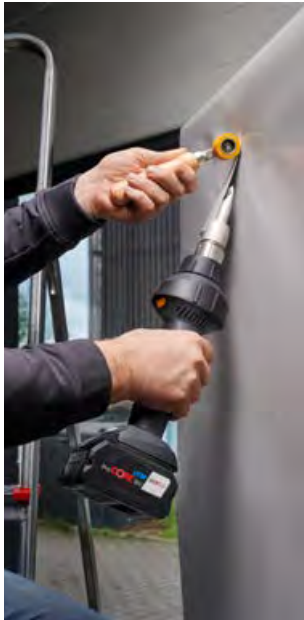
Reparación de lona
